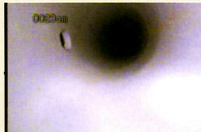
洗管後)管内の夾雑物及び付着物が除去
